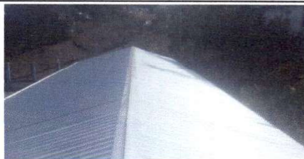
Foto 2: Sustrucción de capote de lamina por lamina troquelada, modulo primaria
