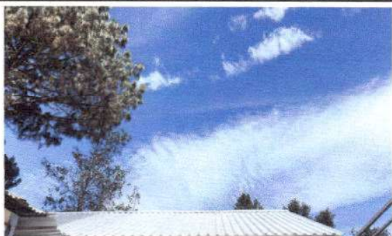
Foto1: Sustrucción de lamina troquelada aluzinc calibre 26 Cocina
