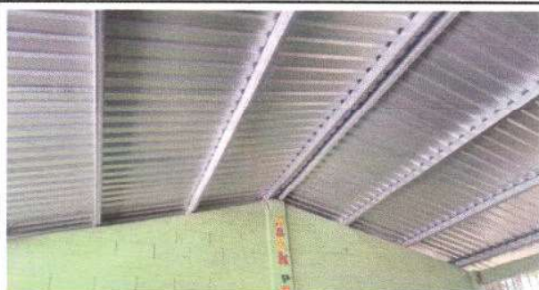
Foto 3: Sustrucción de estructura de soporte de madera por metal aulas primaria
