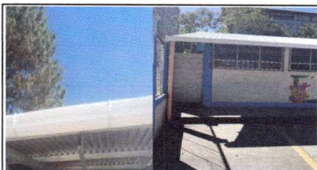
Foto 5: Canales y bajada de agua pluvial modulo cocina y primaria
