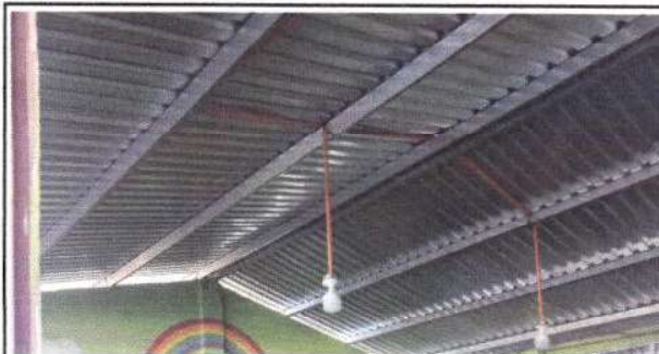
Foto 4: Sustrucción de Estructura de soporte de madera por metal aula parvulos
