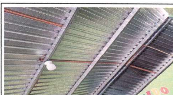
Foto 6: Reparación de Sistema Eléctrico, dirección
